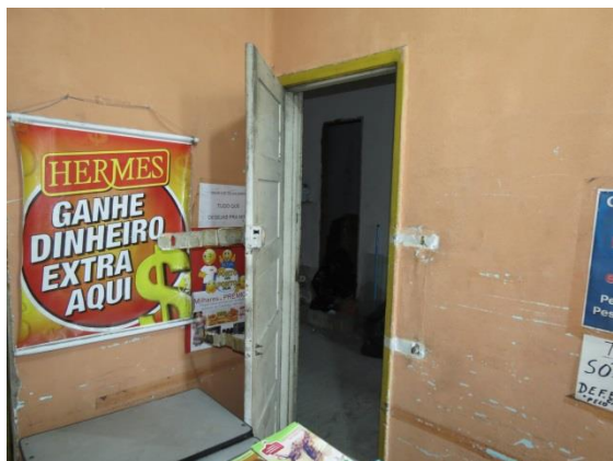
Vista da porta entrada
